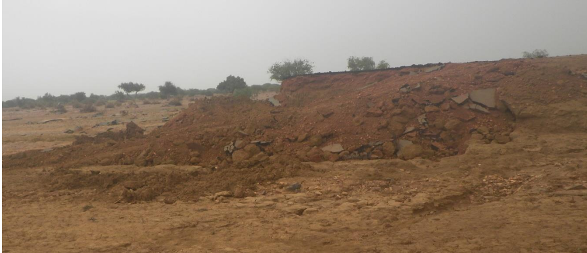
صورة توضح ارتفاع ردمية الطريق العابرة للوادي بالموقع 11 الكيلو 181 والتي أستخدم فيها بعض الـ Pipe Culvert
