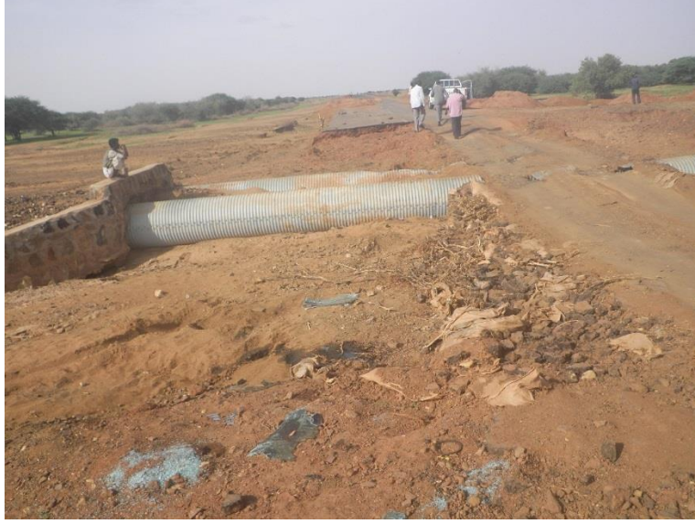
صورة توضح إنجراف الطريق بالموقع رقم 2 بالكيلو رقم 54
