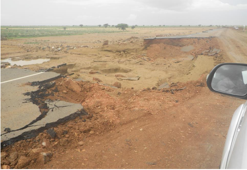
صورة توضح أحد إنجرافات الطريق بالموقع رقم 8 بالكيلو رقم 150
