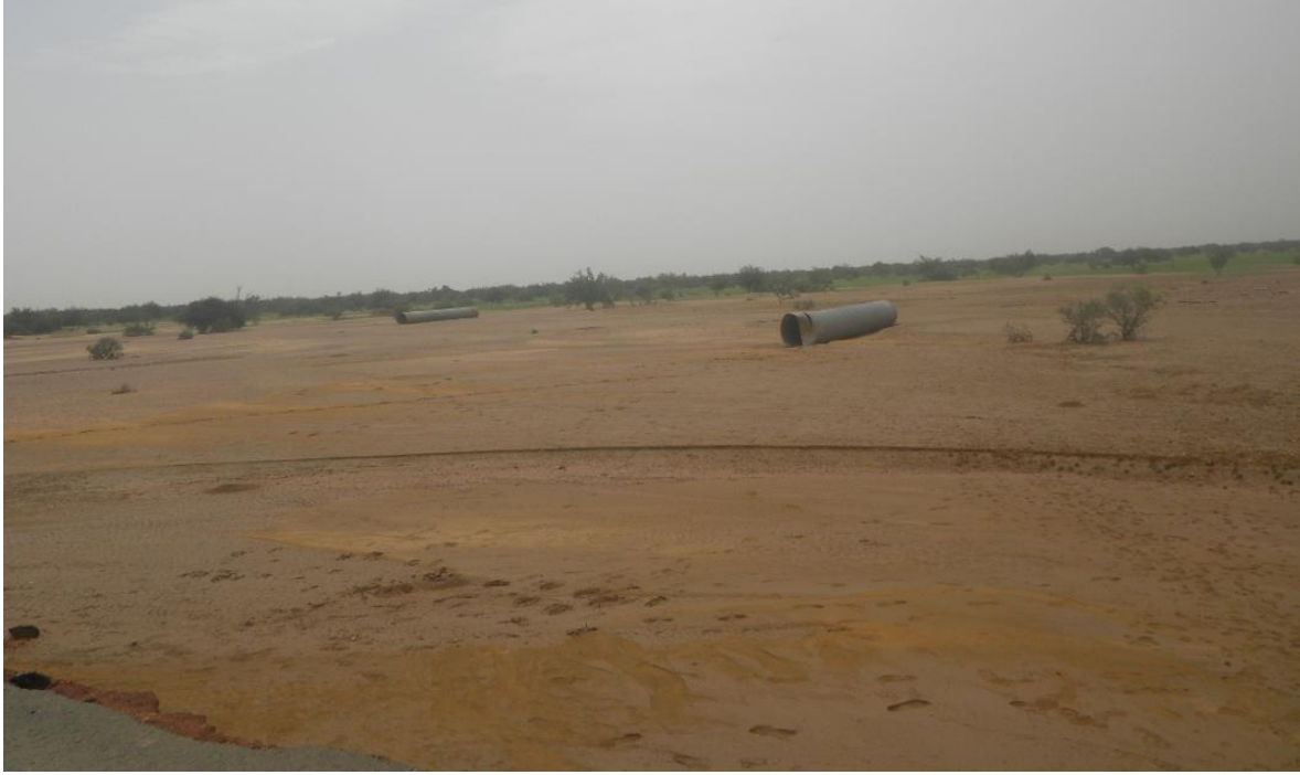
صورة توضح موقع الـ Pipe Culvert بعد ان قذفتها المياه بالموقع 11 الكيلو 181
