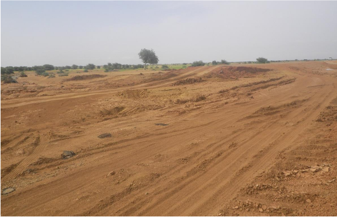
صورة توضح إنجراف الطريق تماماً بالموقع رقم 3 بالكيلو رقم 122
