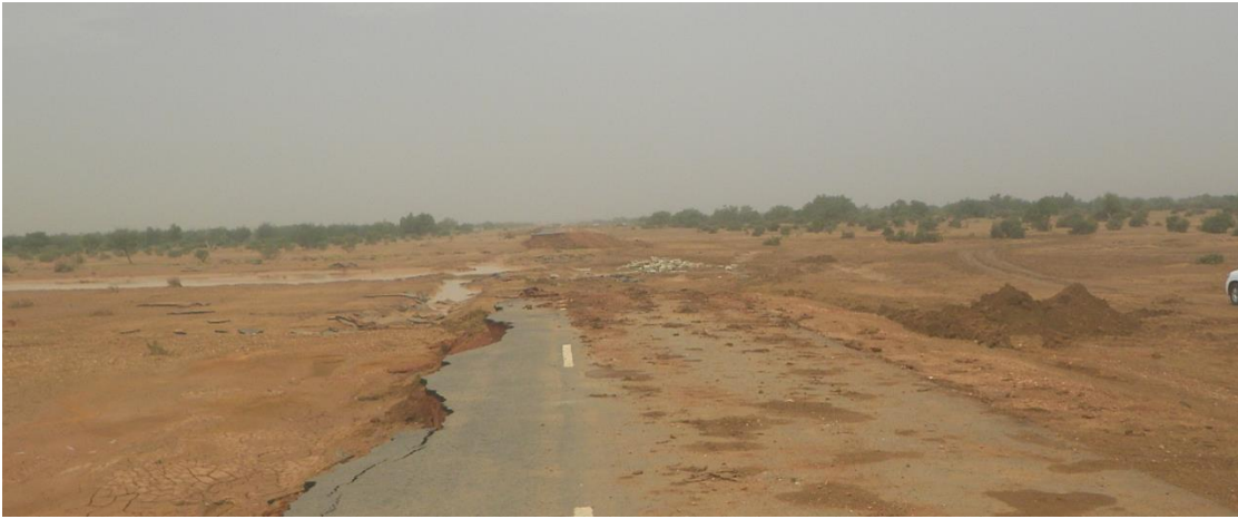
صورة توضح الانجراف الكامل للطريق بمسافة تقارب 200 متر بالموقع 11 الكيلو 181
