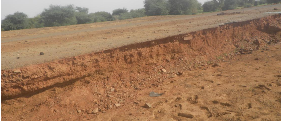
صورة توضح تاكل الطريق بالموقع رقم 2 بالكيلو رقم 54
