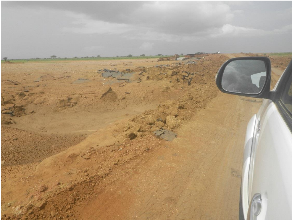
صورة توضح الانجراف الكبير (طويل المدى) للطريق بنفس الموقع رقم 8 بالكيلو رقم 150 (وادي ابو حط)
