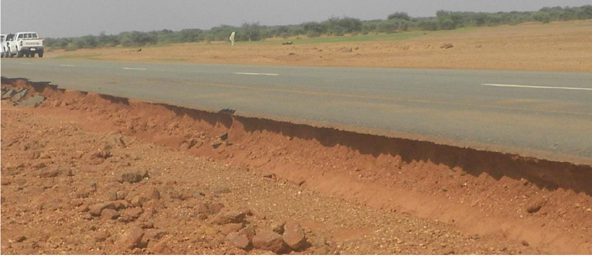
صورة توضح تآكل الطرف الشرقى للطريق بالموقع رقم 3 بالكيلو رقم 122
