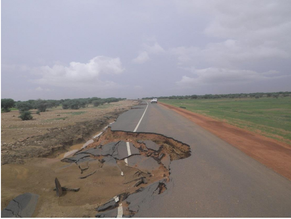
صورة توضح تآكل للطريق بالموقع رقم 4 بالكيلو رقم 143
